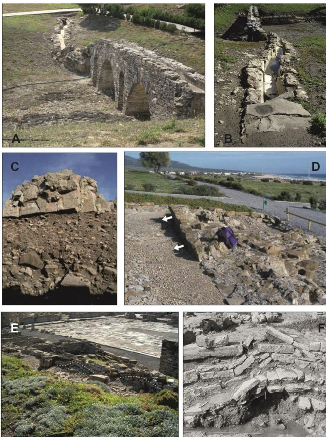
Fig. 7.—EAEs registrados en la zona oriental de Baelo Claudia , Acueducto, Templo de Isis y muros de las tiendas del Foro. A) Vista desde el este del acueducto. Al fondo se observan la serie de planos paralelos que han producido la rotura y desplazamiento rotacional del acueducto; B) Vista longitudinal de las deformaciones registradas en el acueducto desde la zona de la muralla observándose los desplazamientos decimétricos de los diferentes segmentos afectados; C): Muro colapsado sobre los escombros de la parte occidental del Templo Isis mostrando la estratigrafía de los horizontes de destrucción y posterior ruina al terremoto del 260–290 AD; D) Basculamiento a contrapendiente (ladera arriba) de las estructuras murarias frontales del Templo de Isis, consecuencia del proceso de deslizamiento cosísmico que se describe en el texto (ver situación en Fig. 7); E) Estructuras de plegamiento E-O en los muros N-S de la galería oriental de tiendas del Foro consecuencia del proceso de deslizamiento; F) Detalle de uno de los pliegues de los muros orientales del Foro, observándose las deformaciones que afectan al pavimento y estructuras murarias suprayacentes.
