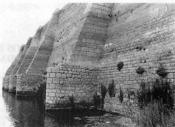
Fig. 1.—Muro del embalse de Proserpina. Los lodos muestreados estaban depositados contra el muro inferior.
